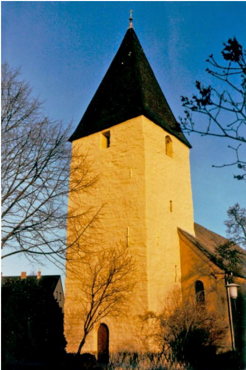
Der romanische Turm nach der Sanierung von 1983. In der Mitte nach Norden und Süden ausgerichtet die nachträglich gebrochenen Schießscharten.
